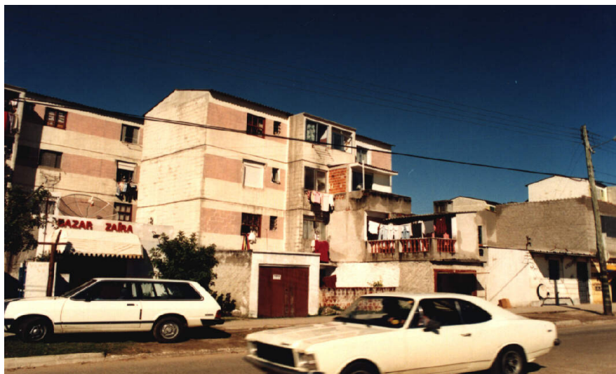
Conjunto Habitacional Guabiroba em 1998: tipologia de 4 pavimentos. Nota-se que as reformas e ampliações já atingem o quarto pavimento. Fonte: Medvedovski (1998).
