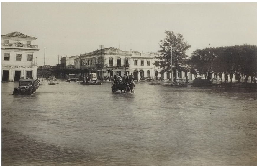
Enchente de 1941 e impactos na área do Porto. Fonte: Acervo fotográfico da Universidade Católica de Pelotas.
