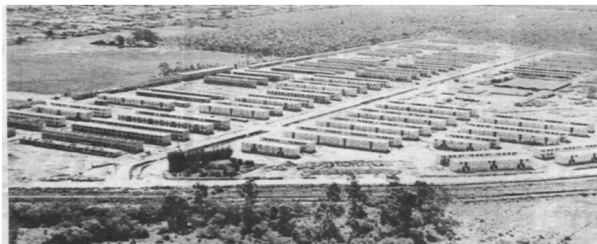
Foto aérea do canteiro de obras do Conjunto Habitacional Lindóia. Na parte inferior, observa-se o antigo leito da via férrea. Fonte: Diário Popular – Pelotas, jul. 1983. Guia da Construção Civil e Mercado Imobiliário.
