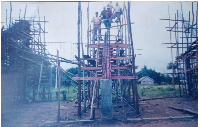
FIGURA 8 - IMAGEM DO INÍCIO DA CONSTRUÇÃO DO TRIBÓDROMO.
